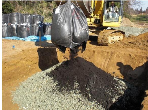
骨材と特殊添加剤を現地でブレンドし、雨水貯留浸透基盤用骨材を製造。製造コストを削減させる。
