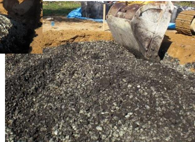
**広大な現場敷地を利用して「雨水貯留浸透基盤材」を現地製造する。**
