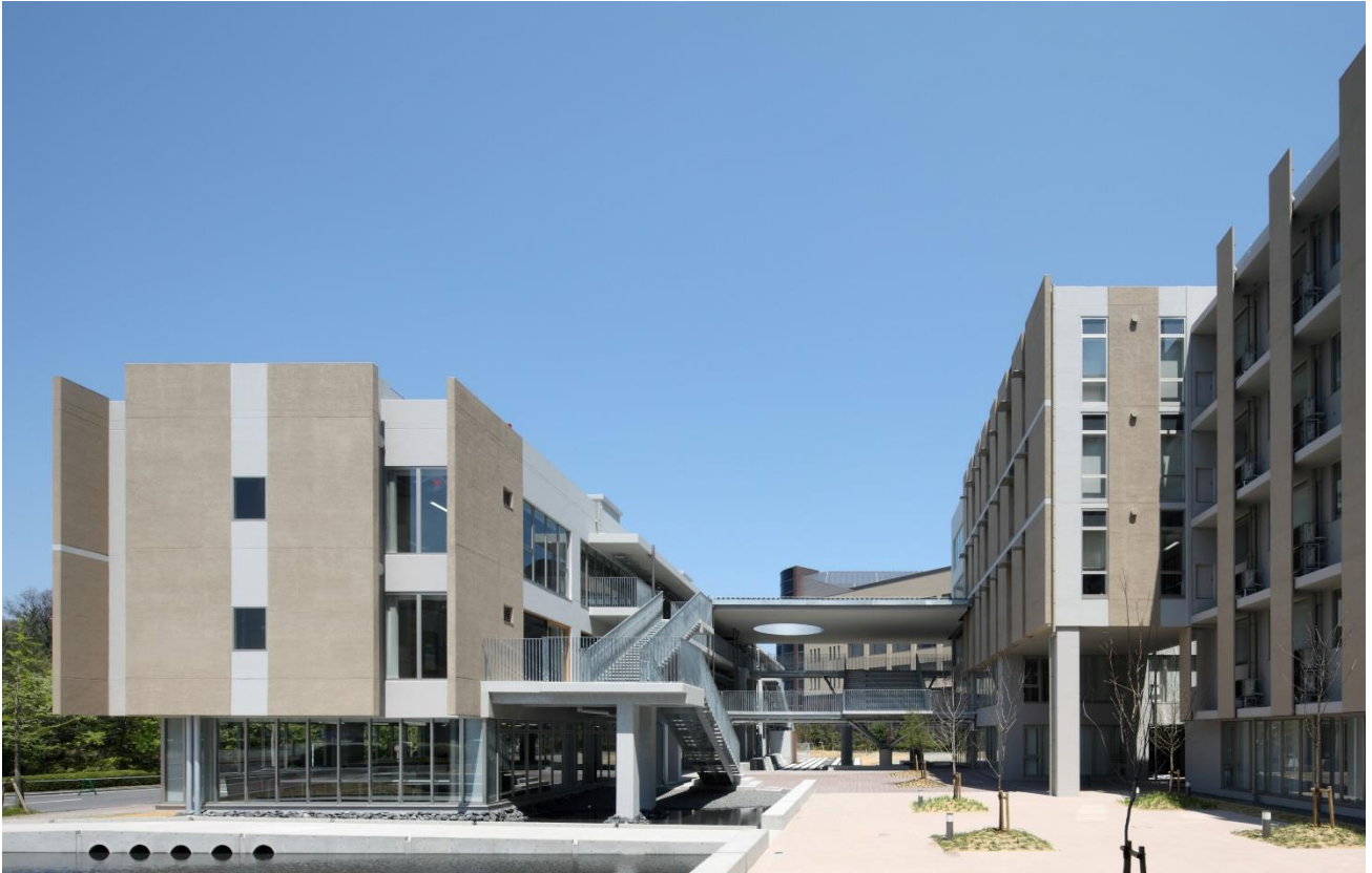
トリシアⅠ・Ⅱ棟間のエントランスコートと雨水貯留池
